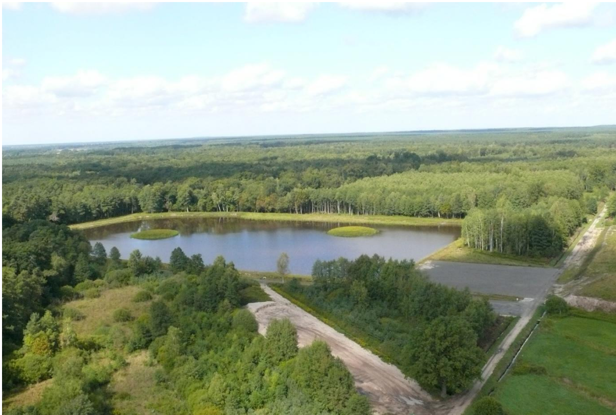
Fot. Zbiornik retencyjny na "Lisich Łąkach" (archiwum Nadleśnictwa Brzeg)
